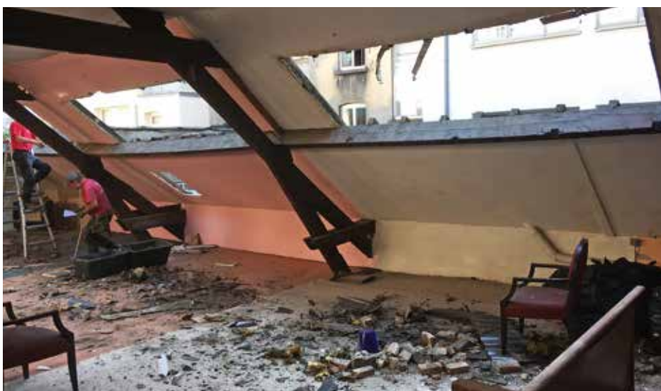
Un nouveau toit sur notre maison de l'avenue Fonsny (Bruxelles).
