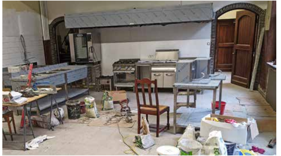
Installation de la cuisine à Courtrai.
