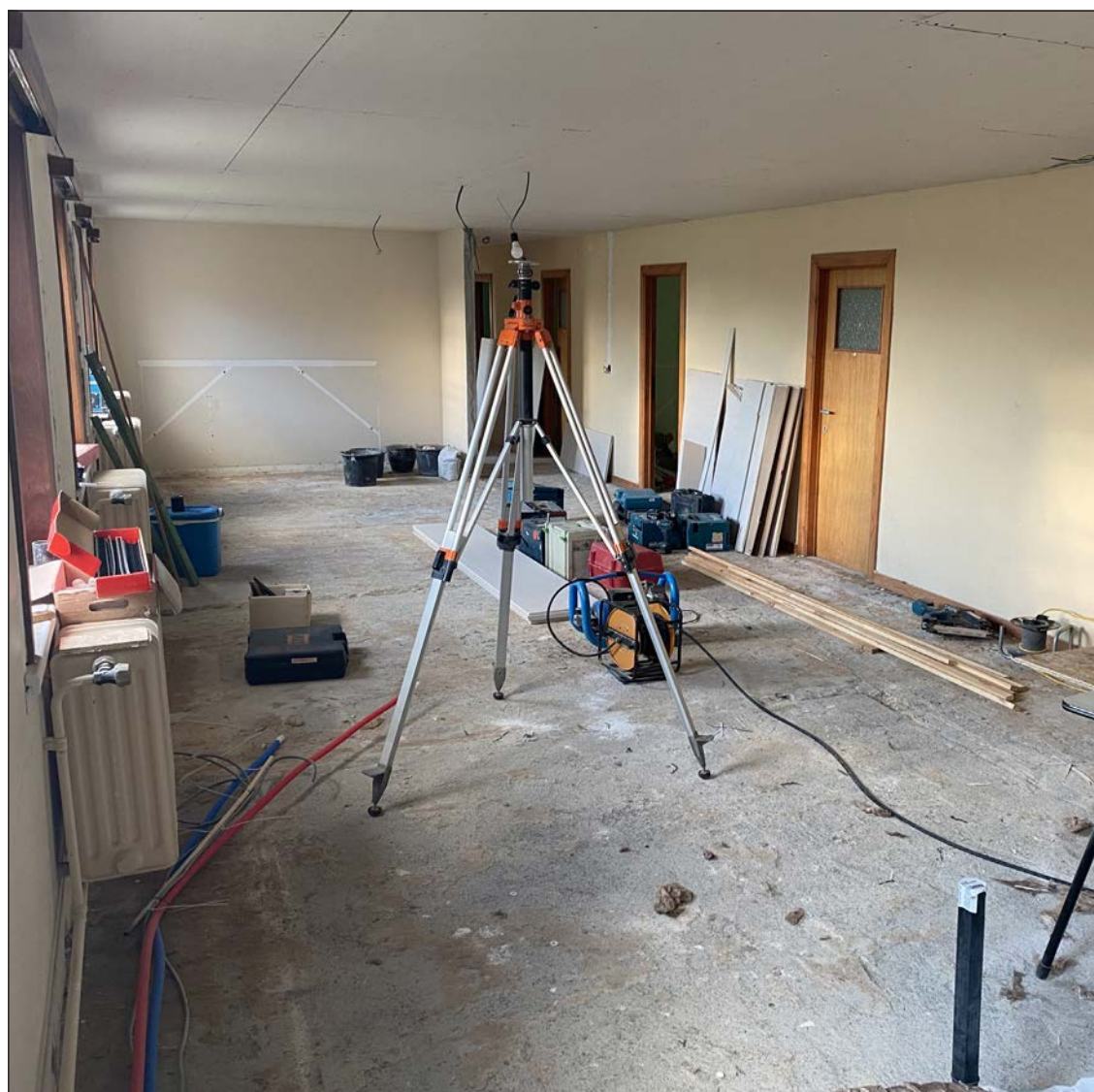
Rénovation d'un lieu de vie pour des séjours temporaires à Zottegem
