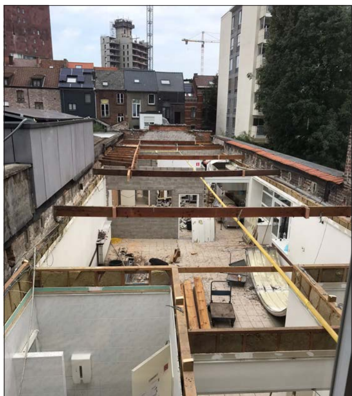
Rénovation du toit à Louvain
